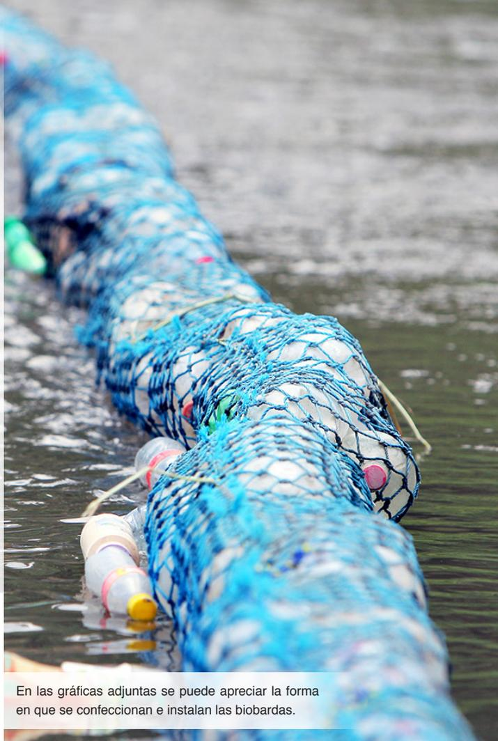
En las gráficas adjuntas se puede apreciar la forma en que se confeccionan e instalan las biobardas.
